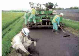
再生アスファルトを活用した農道の簡易舗装 (山形・南国環境保全会)
